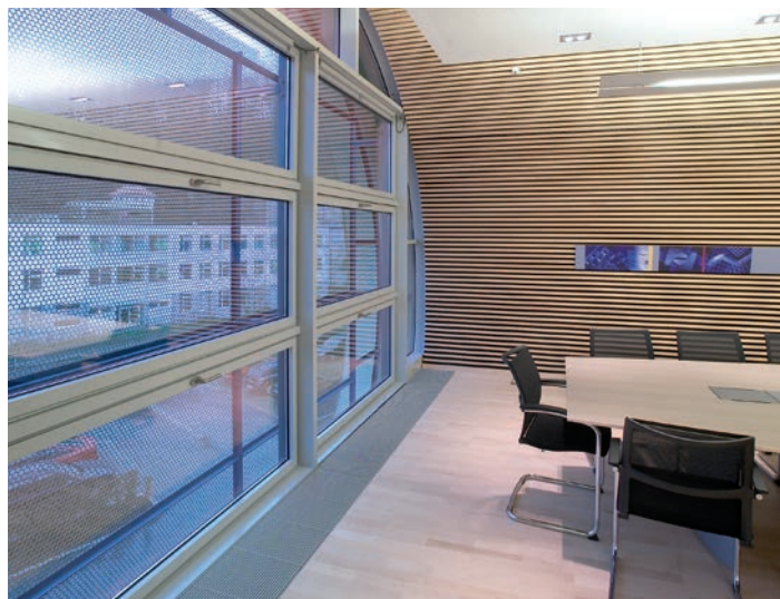
Монтаж на фальш-полу напротив фасада
