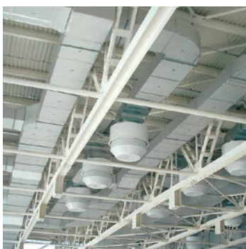
Ангары для окраски воздушных судов
